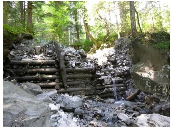
zerstörte Holzsperrre am Läuibach nach Hochwasser
