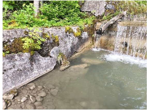
Leitmauer rechts unterhalb Sperre 600 Felsbach
