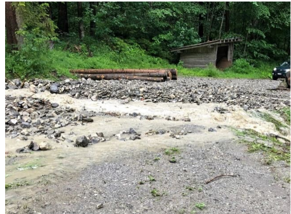
Auflandungen / Überschwemmungen 18. Juli 2022
