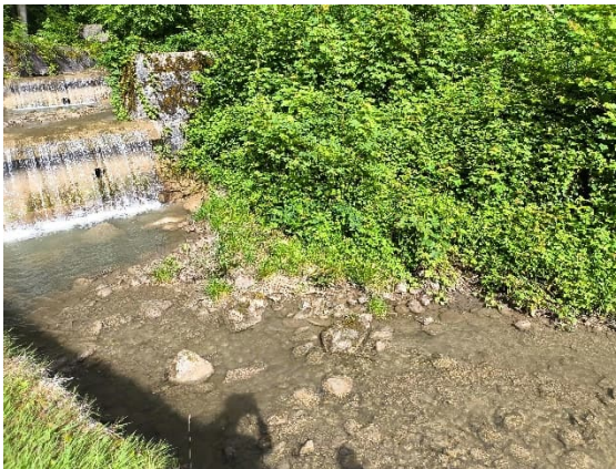
Ablagerungen zwischen Sperre 595 und 597 Felsbach
