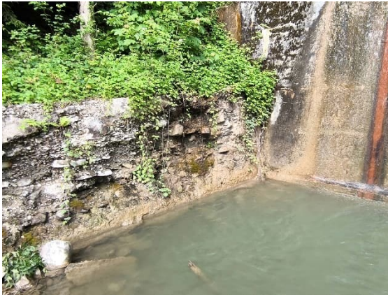
Leitmauer rechts unterhalb Kiesfangsperre 604 Felsbach
