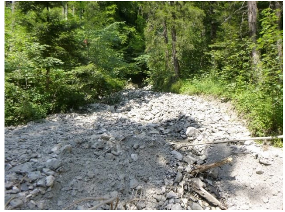
oberhalb Durchlass ca. km 0.800 Lauibach nach Hochwasser
