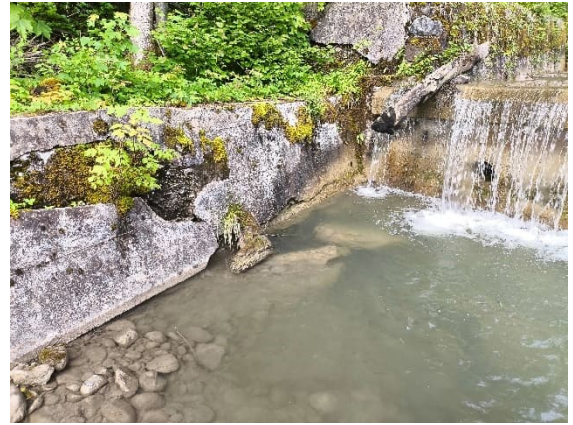
Leitmauer rechts unterhalb Sperre 600 Felsbach
