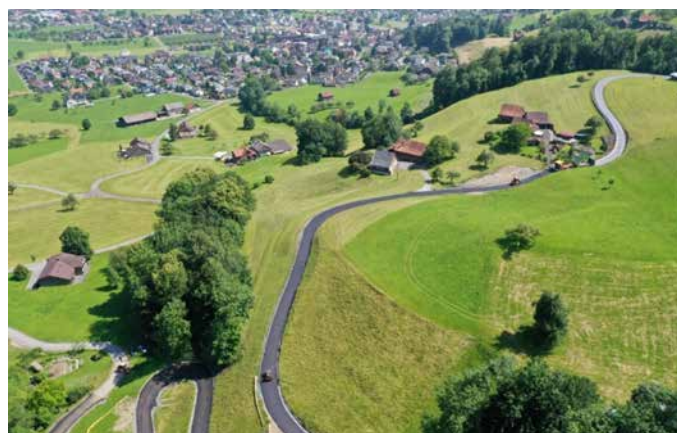
Drohnenaufnahme der Belagsarbeiten bei der Sanierung der Müntschenbergstrasse vom 12. Juni 2025
