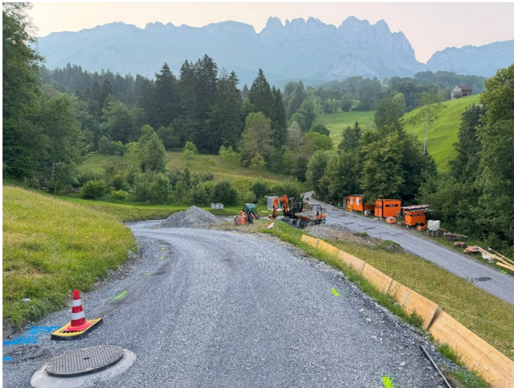
Feinplanie der Strasse, kurz vor dem Belagseinbau (Aufnahme 11.06.25)
