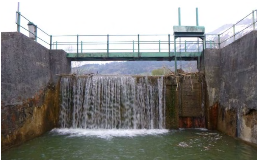
Abbildung 4: Auslaufbauwerk Kiesfang Chessi
