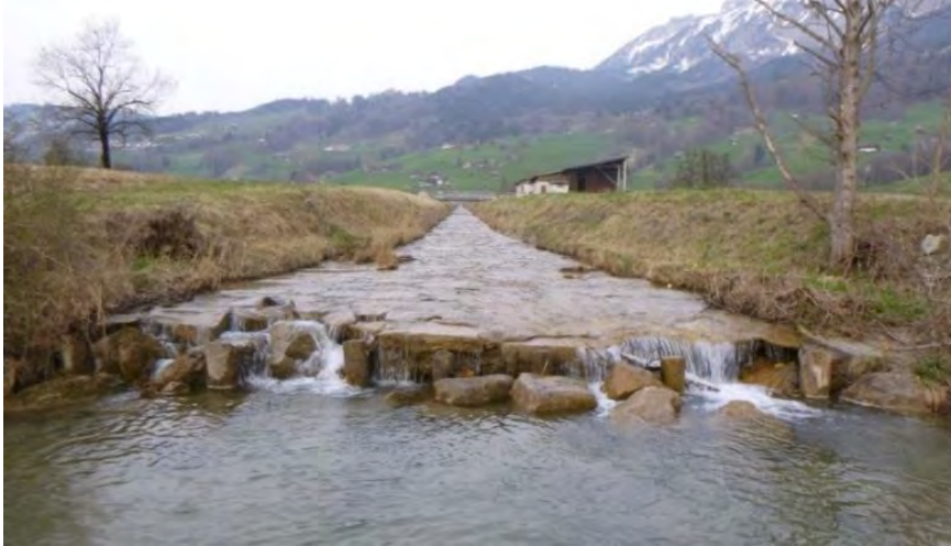
Abbildung 3: Einlaufbauwerk Kiesfang Chessi
