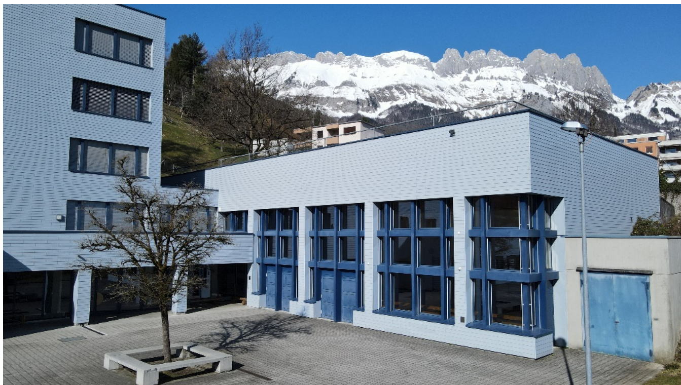
Turnhalle und Gemeindesaal «Widem» mit angebautem Geräteraum
