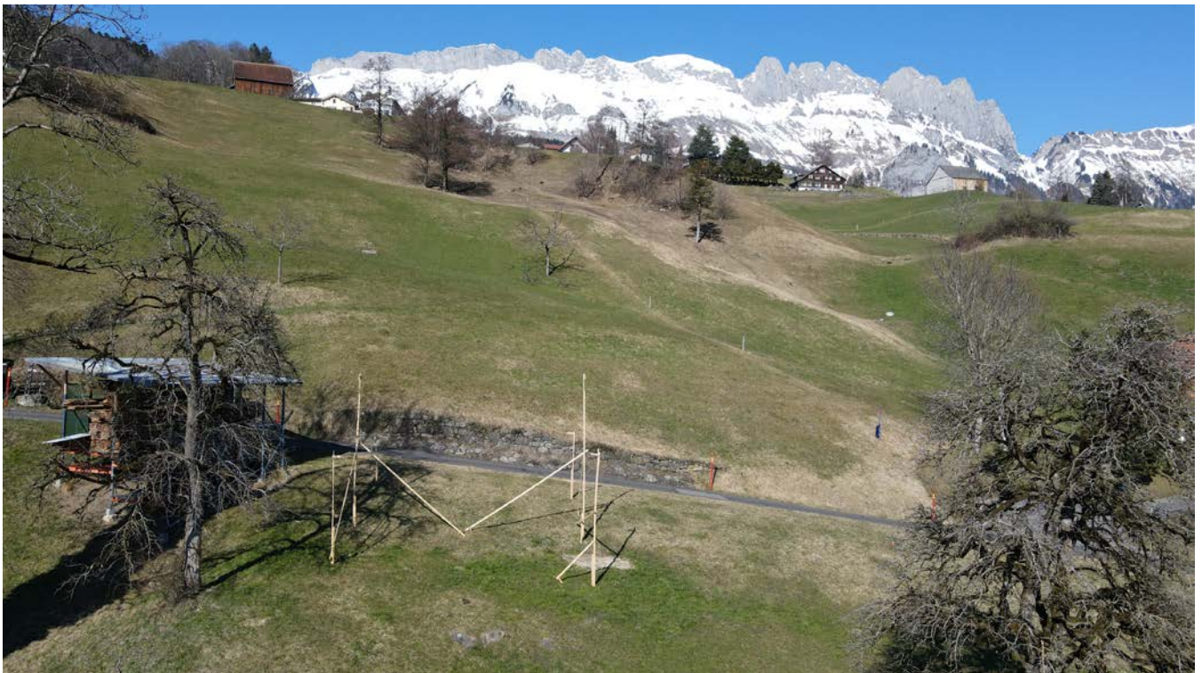
Visiere des Zugangbauwerks am Standort «Bruedermäl» (Reservoir unterirdisch)
