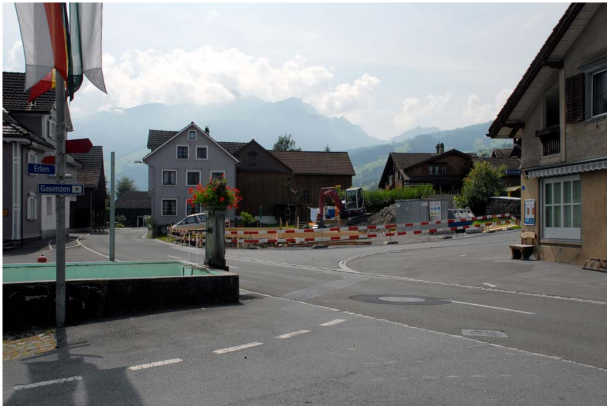
Auf dem Gasenzenplatz entsteht ein neues Gebäude mit Haltestelle und gedeckten Parkplätzen.
