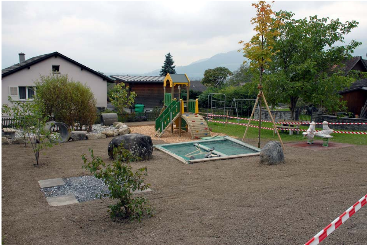
Spielplatz „Lungalid“ kurz vor Fertigstellung
