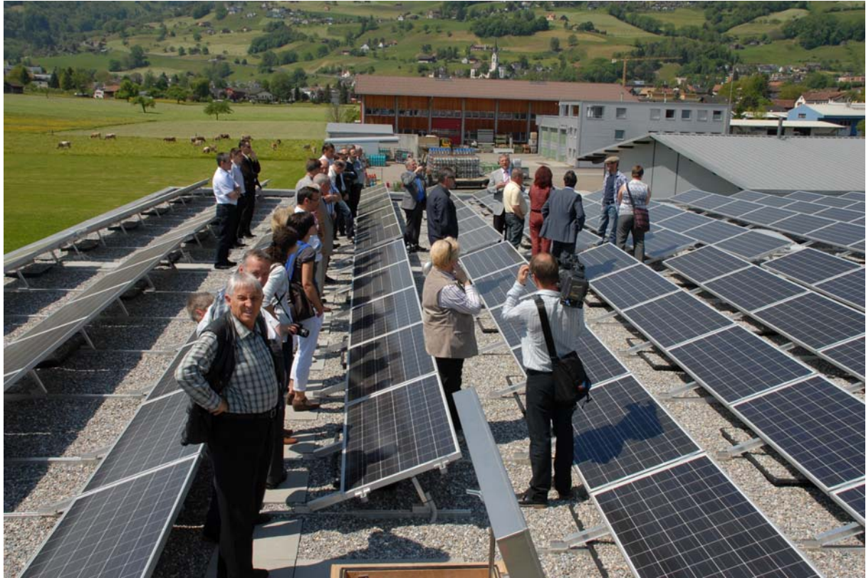
Tag der offenen Tür am Tag der Sonne bei strahlendem Wetter bei der Heizplan AG, Gams
